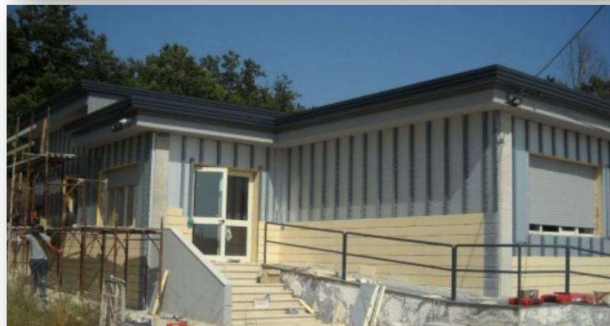
Spessori di materiali necessari ad ottenere  $U = 0,18 \text{ W/m}^2\text{K}$  o  $R = 5,45 \text{ m}^2\text{K/W}$
